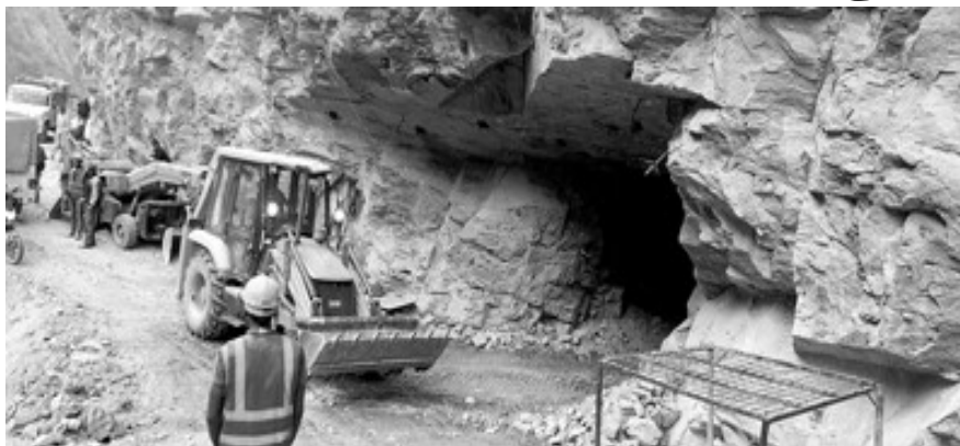
कालीकोटमा निर्माणाधीन फुकोट कर्णाली हाइड्रोको सुरुङ निर्माण गरिँदै । तस्विर : मिसन न्यूज
