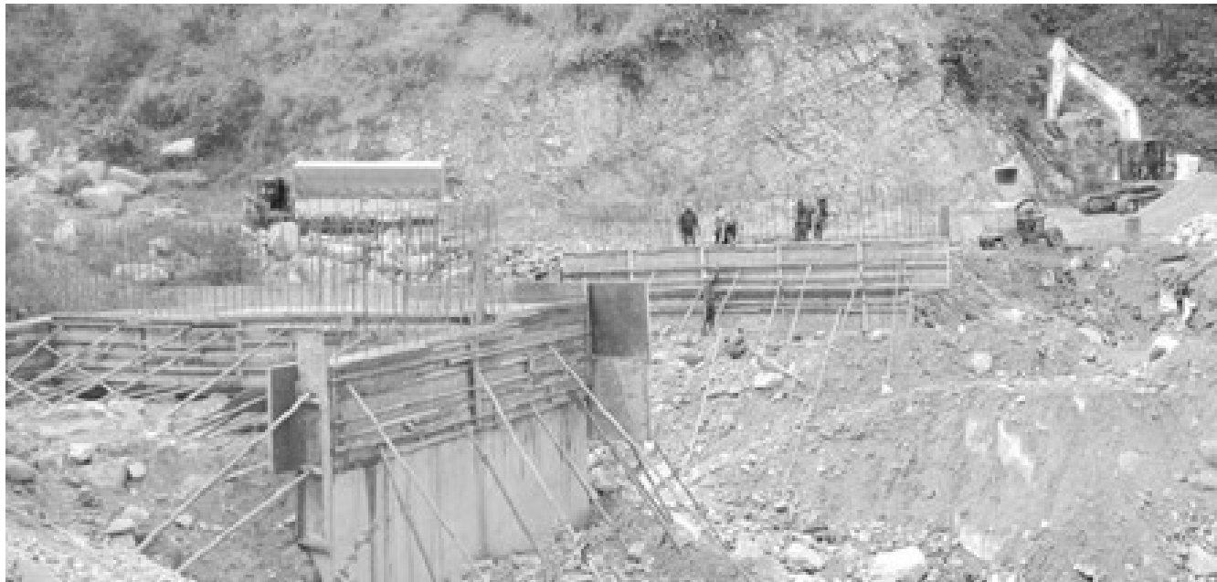
कर्णाली राजमार्गको दहिखोलामा निर्माणधिन पुल ।
