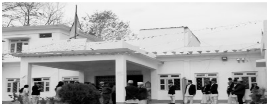
कर्णाली प्रदेशमा रहेको प्रदेशसभा भवन ।
