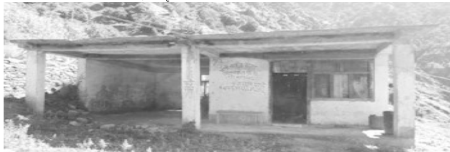
कालिकोट जिल्लाको खाँडाचक्र स्थित ताडिमा निर्माण गरिएको संकलन केन्द्र ।
