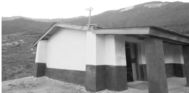
सान्निविषी गाउँपालिकाले जडान गरेको वलडलिकको नेट ।
