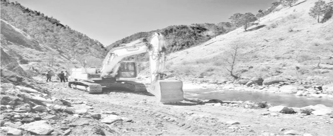
मुगुको नाक्चेनाग्ला-तिब्बतखण्डको छाइल भीरमा सडक निर्माणमा जुटेको डोजर ।
