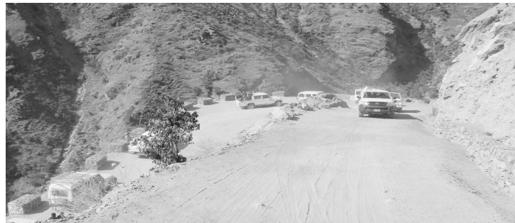
ग्रामिण पहुँच कार्यक्रम तेस्रोले निर्माण गरेको सानीघाट-स्युना-सिपखाना सडक ।
